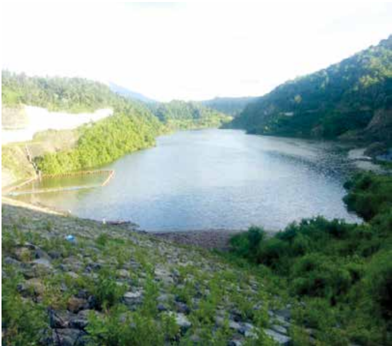
Gambar A.5.3. Pemandangan Bendungan Titab (Source: Arsip DISPAR)
